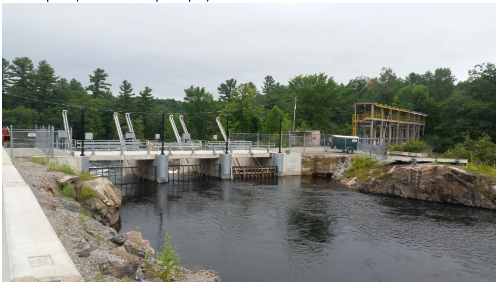
Photo 3 Bassin d'admission aux turbines VLH MC des chutes Wasdell
